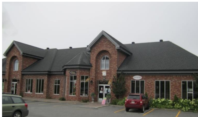
Photo 2: Bâtiment commercial sur le chemin Ozias-Leduc.
