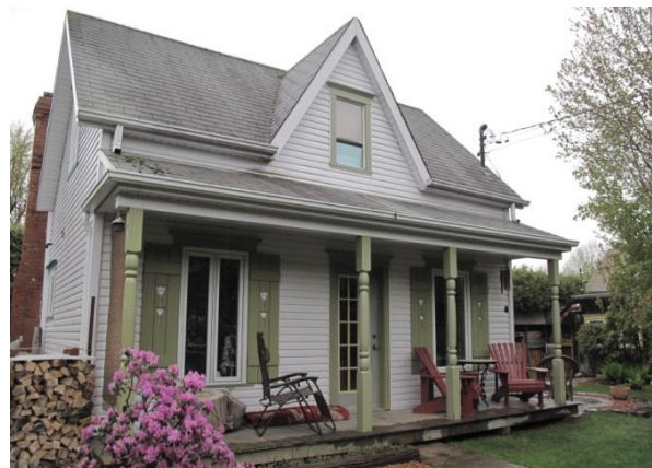
Photo 15: Maison typique du Vieux-Otterburn.
