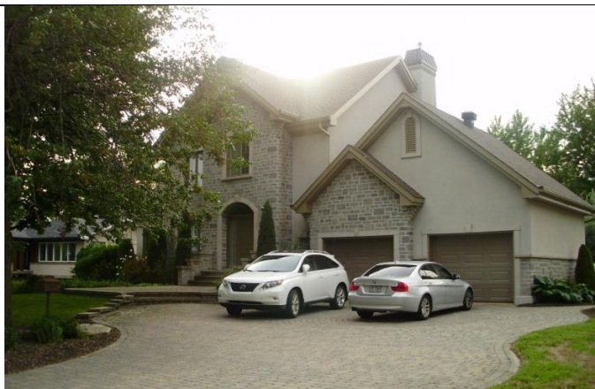
Photo 41: Construction récente en bordure de la rivière.
