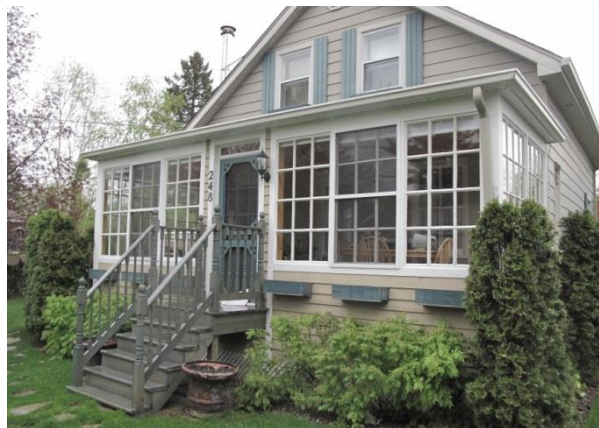
Photo 14: Maison typique du Vieux-Otterburn.
