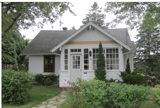
Photo 23: Maison typique Secteur du Vieux-Otterburn/ Pont-Noir.
