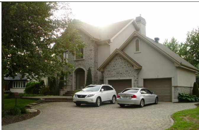
Photo 41: Construction récente en bordure de la rivière.
