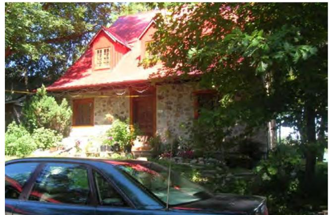
Photo 51: L'utilisation de la pierre des champs, la présence de lucarnes, le toit en tôle à baguettes et le cadrage en bois témoignent de l'importance de l'utilisation de matériaux durables et reflète une composition architecturale
